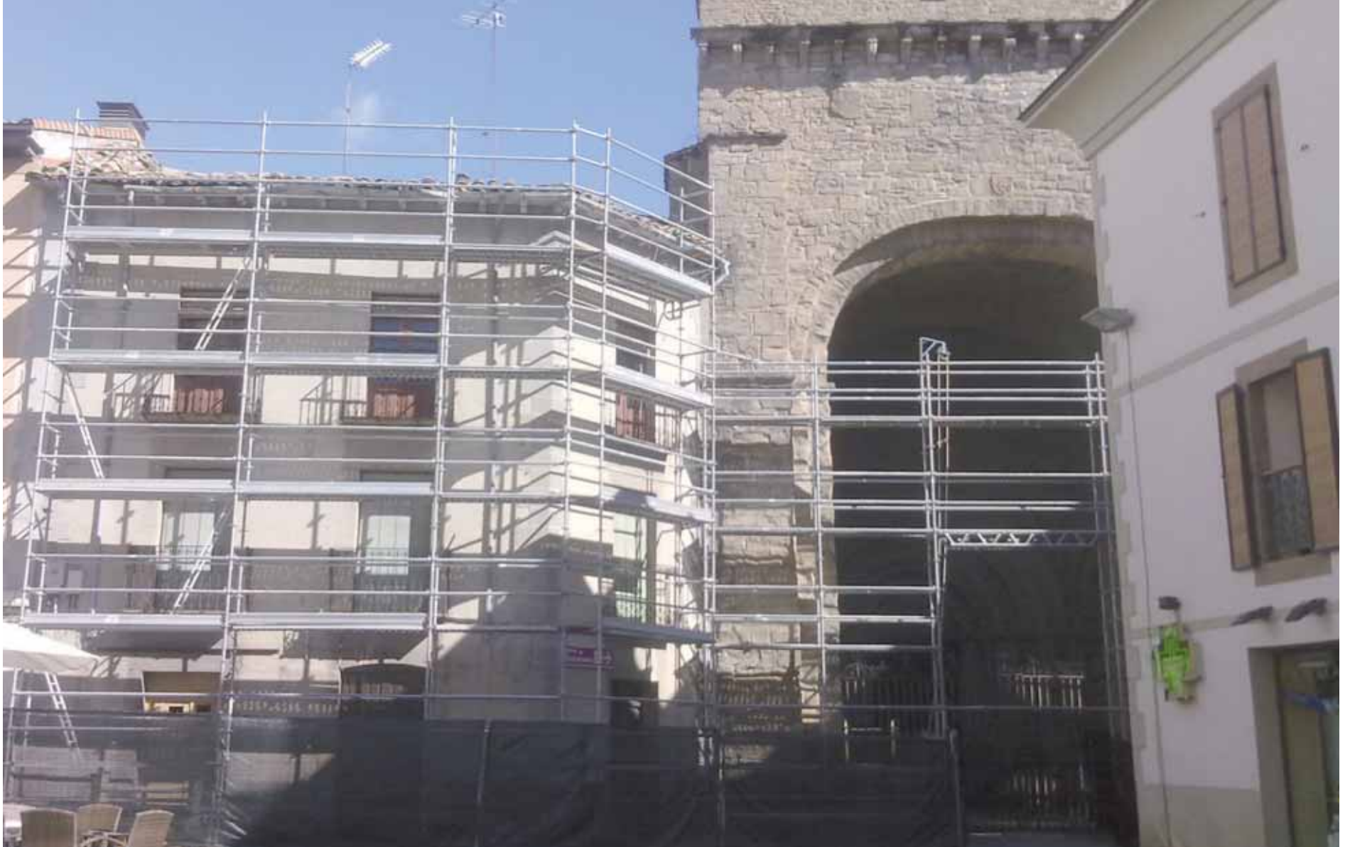
Obras en la longa principal de la catedral.
